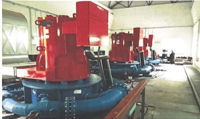
Slika 18: Mašinska zgrada mHE Jara
